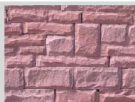
تصویر شماره ۱۹.۴. دیوار چینی با سنگ بادکوبه‌ای
