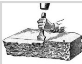
تصویر شماره ۱۷.۴. تراشیدن لبه‌های سنگ بادکوبه‌ای
